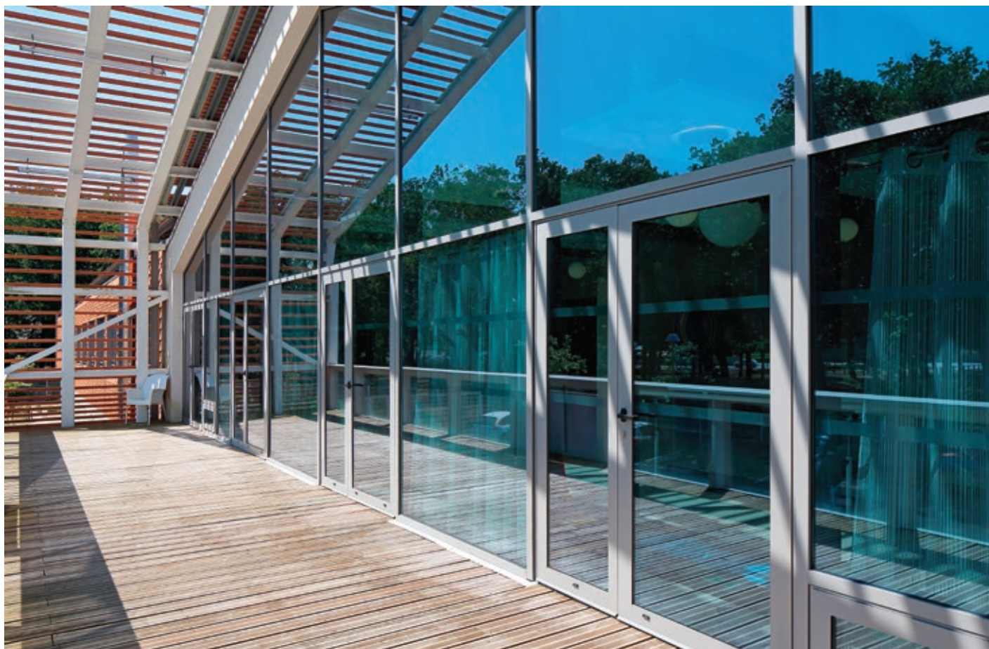
Magnolias Biganos (33) - Architecte : LANKRY (93) - Entreprise : Richard SA (33) - Photo : Patrick Loubet
